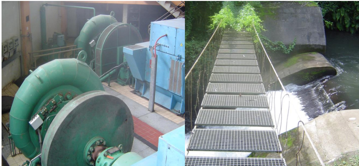
Ilustración 5: Turbina Francis y toma de agua, de la central hidroeléctrica de Riaba.
